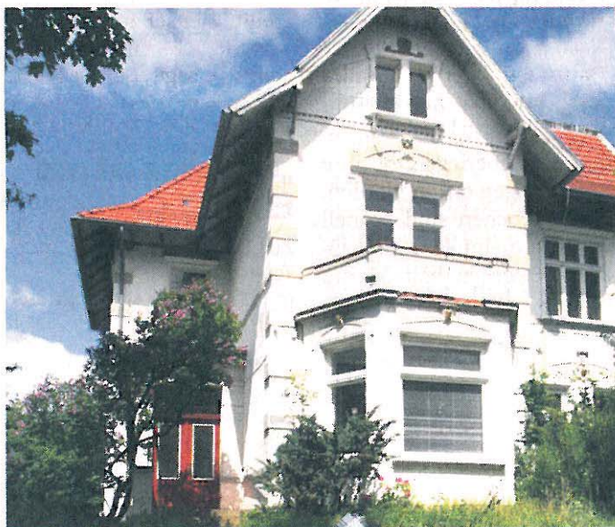
Diese Villa an der Plöner Straße soll abgerissen werden. M. KUHR
