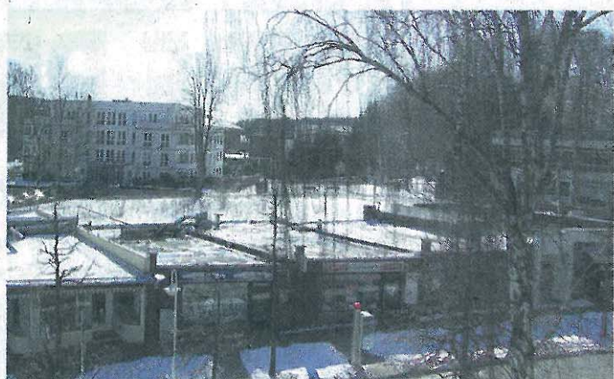
Blick auf den Bauplatz: Vor dem Bellevue (links hinten), dem Haus des Kurgastes (rechts) und an der Bahnhofstraße (vorne) sollen in den nächsten Jahren drei Gebäude entstehen. SCHRÖDER
