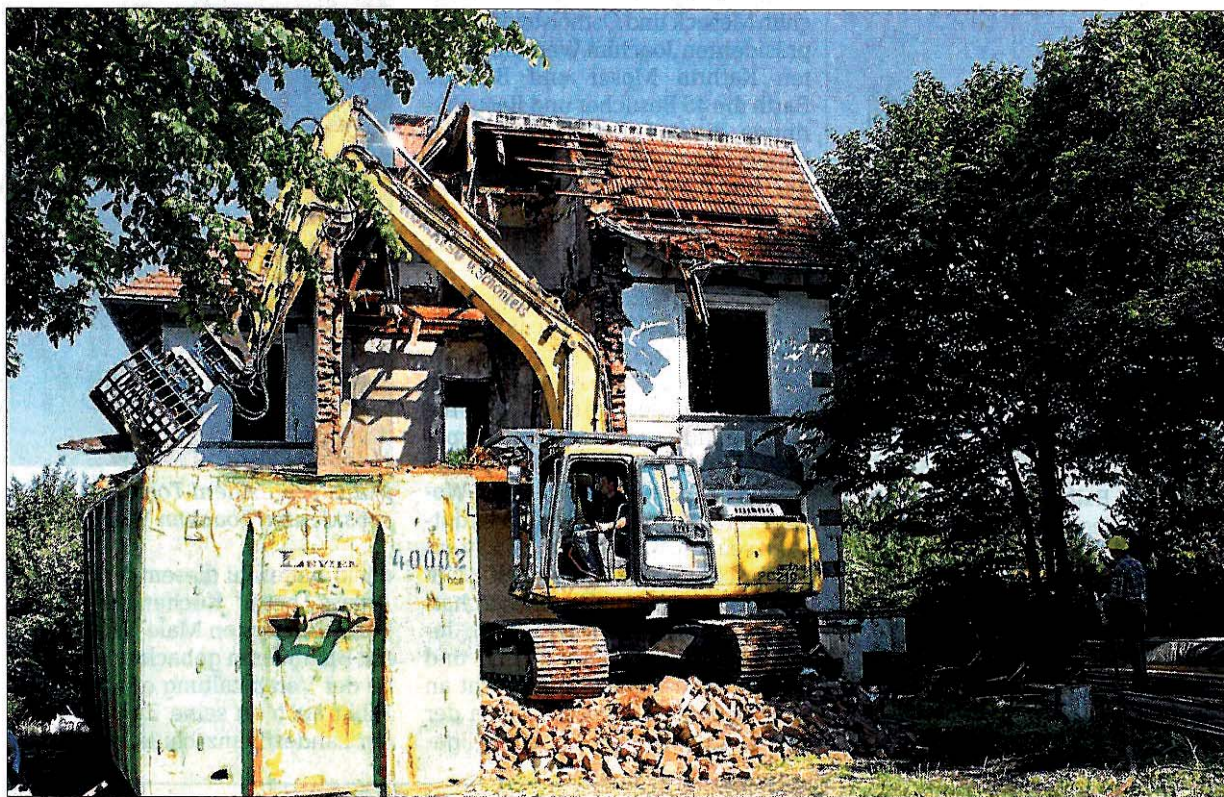
Der Bagger packt zu, und ein vertrauter Anblick in der Plöner Straße verschwindet.
