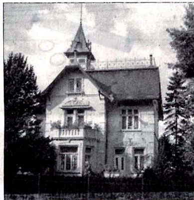
So prächtig sah sie um 1940 aus: die Villa an der Plöner Straße 82. Jetzt ist der Abrissbagger am Werk.
